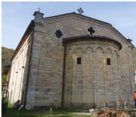
Сл. 1. Поглед кон источната фасада, црква Св. Никола , с. Вевчани
